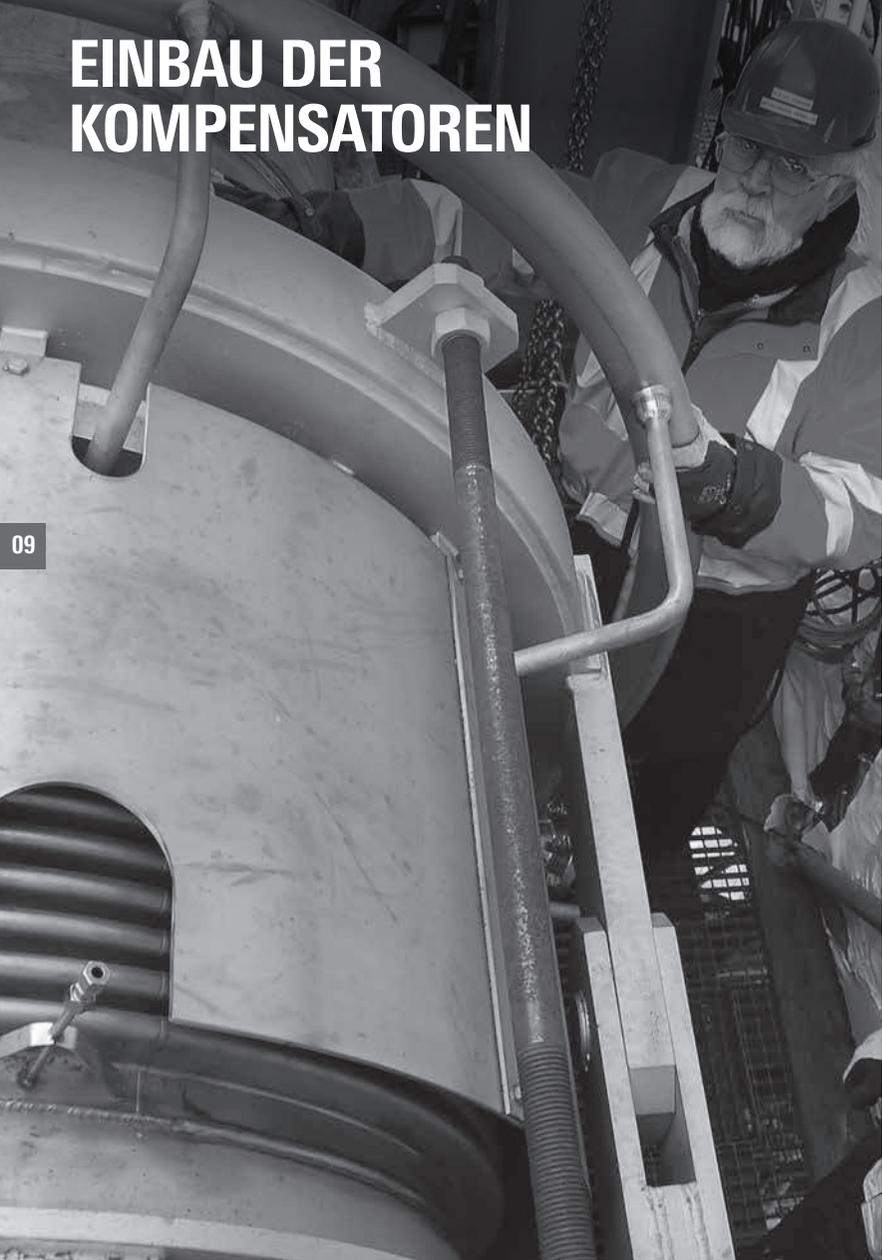
Durch den Einbau von Kompensatoren in eine Rohrleitung verändert sich deren Verhalten zum Teil erheblich. Festpunkte und Führungen werden anders beansprucht und müssen andere Aufgaben übernehmen als bei einer unkompensierten Leitung.
