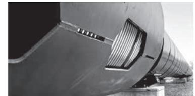
Bild 12.13 Druckentlasteter Axial-Kompensator, Prinzip Ringraum, in Fernwärmetransportleitung DN 1000
